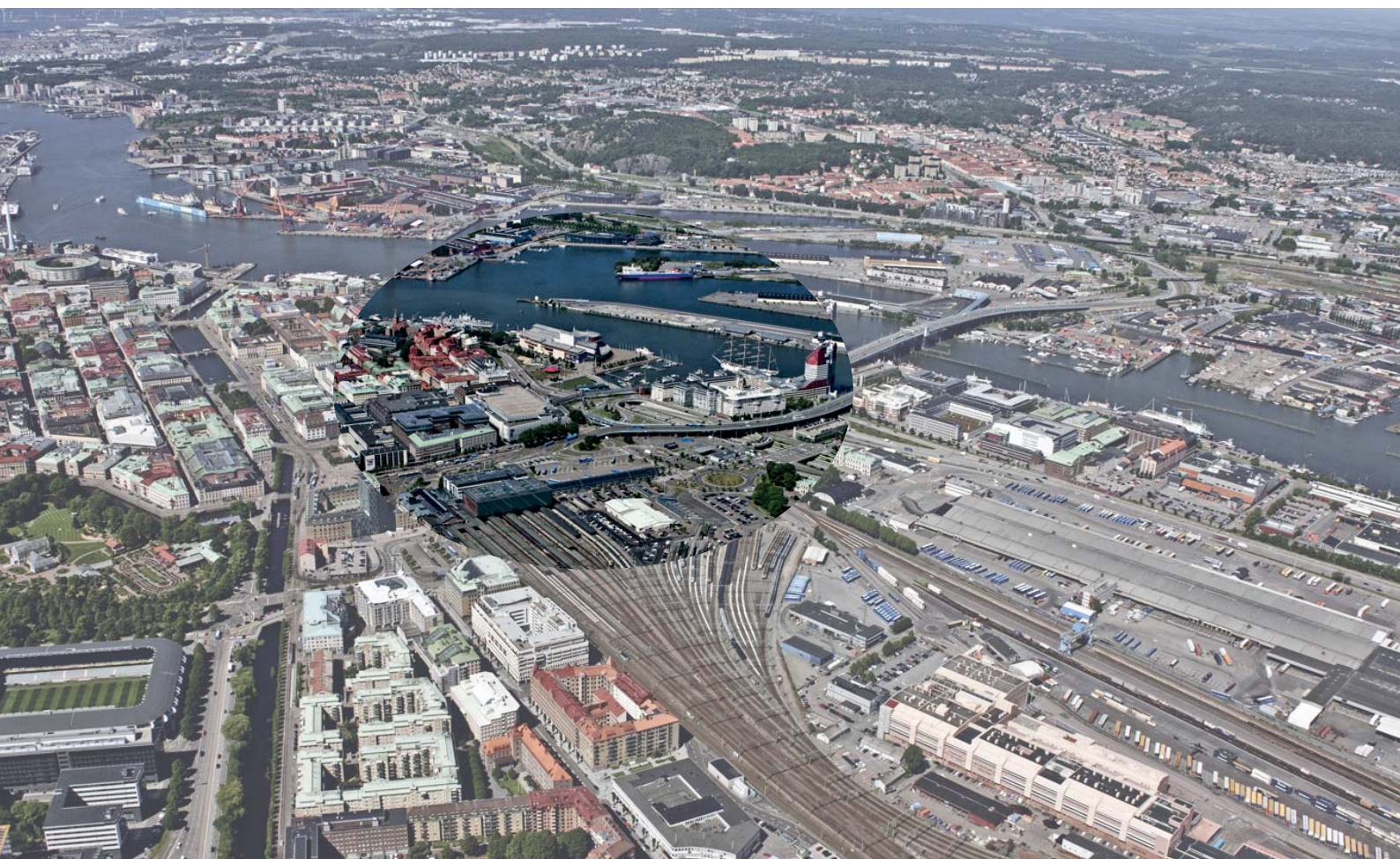
Vy från sydost med detaljplaneområdet i centrum.
